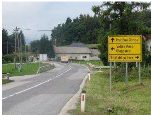
Slika 15: Nevarno prečkanje pešcev in kolesarjev regionalne ceste Ivančna Gorica – Šentvid – Radohova vas
